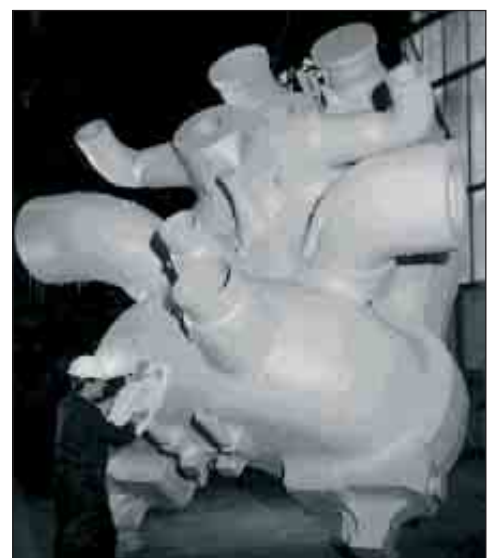
Bild 70: Außengehäuse einer Turbine mit angeschweißten Krümmern aus G17CrMoV5-10
