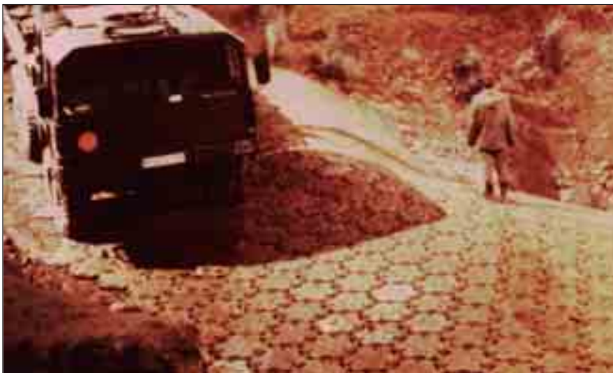
Bild 53: Sechskantverbundplatten für mobile Oberflächenbefestigung aus GE260, Plattengewicht 23 kg
