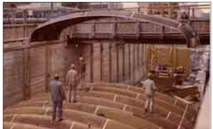
Die Deckenteile für die Gelsenkirchener U-Bahn bestehen aus G16Mn4-Elementen, die durch Konstruktionsschweißen miteinander verbunden sind
