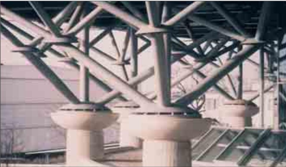
Stahlbaukonstruktion am Tagungszentrum Hannover mit gegossenen Knotenteilen (Teilbilder rechts) aus G20Mn5, normalisiert Kapitell-Aufsatz mit Pylonanschluss aus G20Mn5 N, Dmr. 1,78 m, Masse 4 t (rechts oben) Kapitell-Aufsatz aus G20Mn5 N, Dmr. 1,54 m, Masse 2,05 t (rechts unten)
