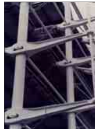
Stahlschleudergussrohre und Kragarme aus G22CrMnMo4-4 tragen die Außenkonstruktion des „Centre Pompidou“ in Paris
